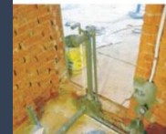
水路管路測試
