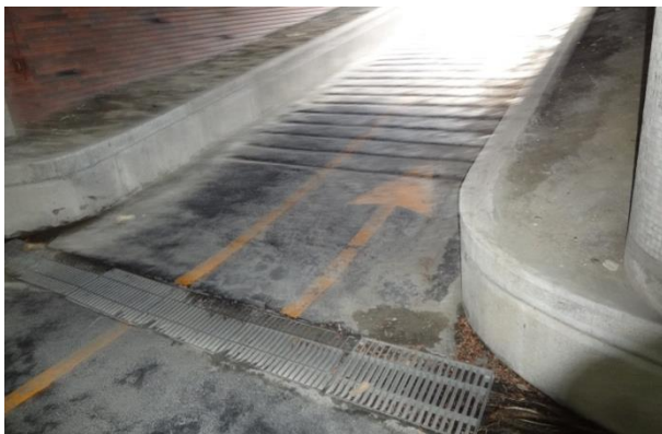
車道水溝 清淤投菌
