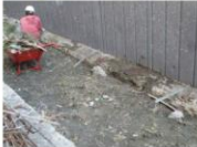
工務所旁雜草及環境髒亂，派員將環境整理。
