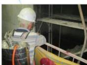
派員將工區內電梯坑內積水抽除及垃圾清除。
