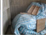
工區內物料堆置區派員噴藥處理，改善作業完成。
