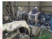
工區內鄰近長榮路路口處派員及環保車清除垃圾清理環境。
